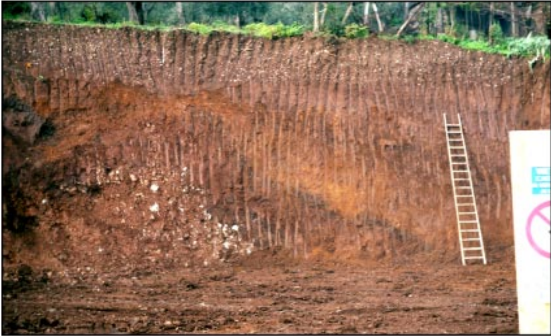
Fig. 4 - Affioramento di depositi essenzialmente siltoso-argillosi di origine vulcanica nel centro abitato di Cautano in corrispondenza dell'antico lavatoio. Vedi testo.
